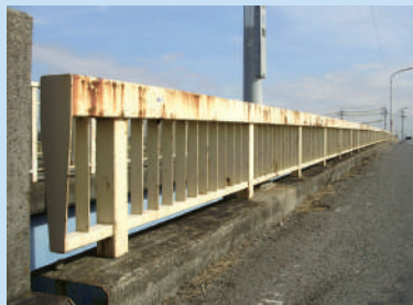
観音寺橋(愛知県) 【補修前】
