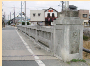
年谷橋(京都府) 【補修前】
