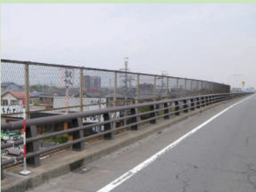
蟹江高架橋(愛知県)【補修前】
