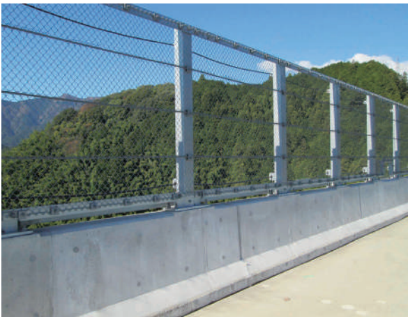
中部横断自動車道(静岡県)
