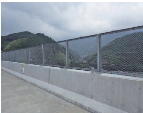
中部横断自動車道(静岡県)
