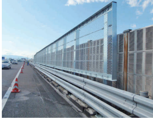
名神高速道路 二子高架橋(愛知県)
