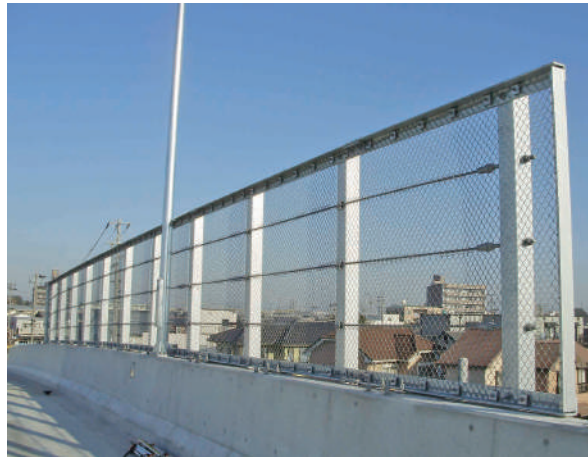
桃栄跨線橋(愛知県)
