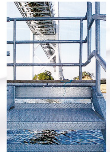
点検歩廊 瀬戸大橋 検査路(2007年11月施行)
