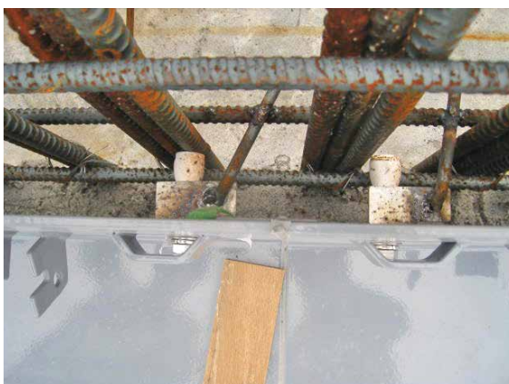
3. アンカーバーを地覆の組立て鉄筋に固定します。
