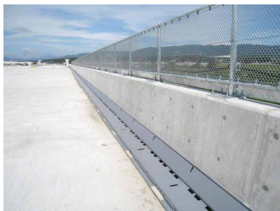
4. 地覆を流し込み、蓋をセットしたら完成です。
