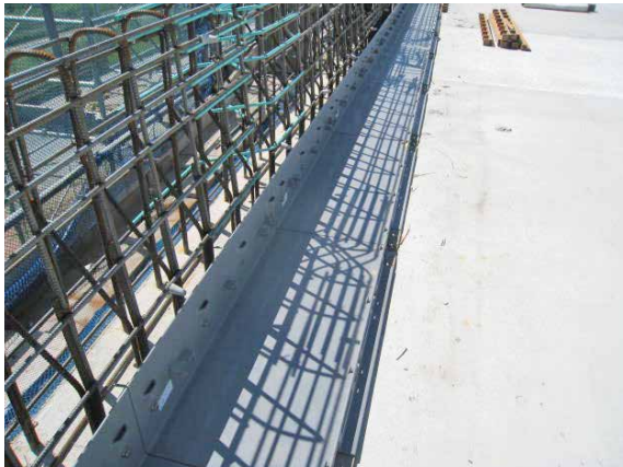
1. 鋼製排水溝を設置します。
