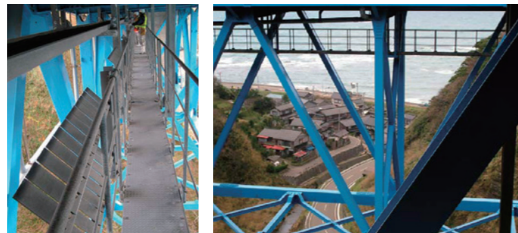
試験場所 北陸自動車道 徳合川橋
