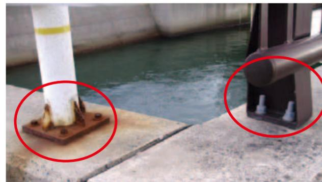
高欄本体の耐食性が高くてもアンカーボルト、セットボルトが早く錆びて強度不足に
