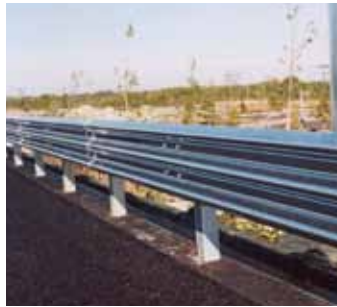
ガードレール
