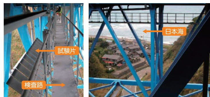
試験場所 北陸自動車道 徳合川橋 検査路 (試験開始: 2001年6月)
