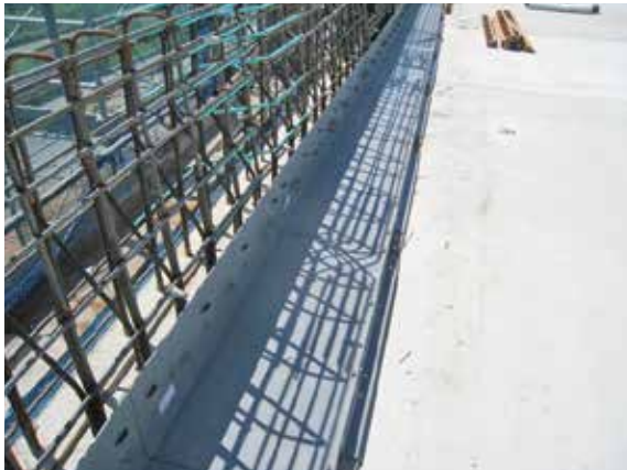
1. 鋼製排水溝を設置します。
