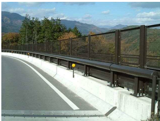
城山歩道橋（長野）
